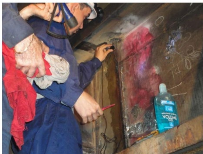
Рис. 6 - Зварювання на бічній оболонці перевіряється за допомогою проникаючого барвника та ультразвукового обладнання для виявлення дефектів
