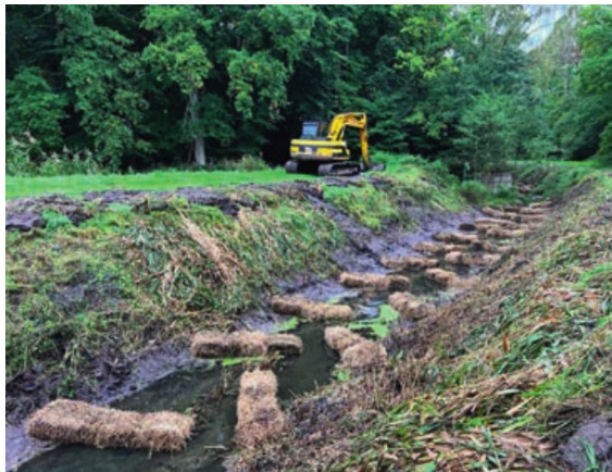
Рисунок 1 - Приклад використання солом'яних цеглинок у скидному каналі ставка у вигляді ялинки для збирання осаду з подальшим використанням в якості субстрату для вирощування грибів
